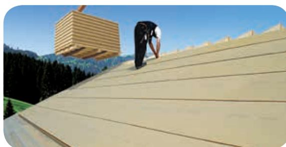
Sous-couverture résistant aux intempéries pendant 12 semaines en tant que toiture provisoire
