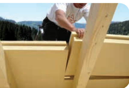
Pose directement sur le chevron
