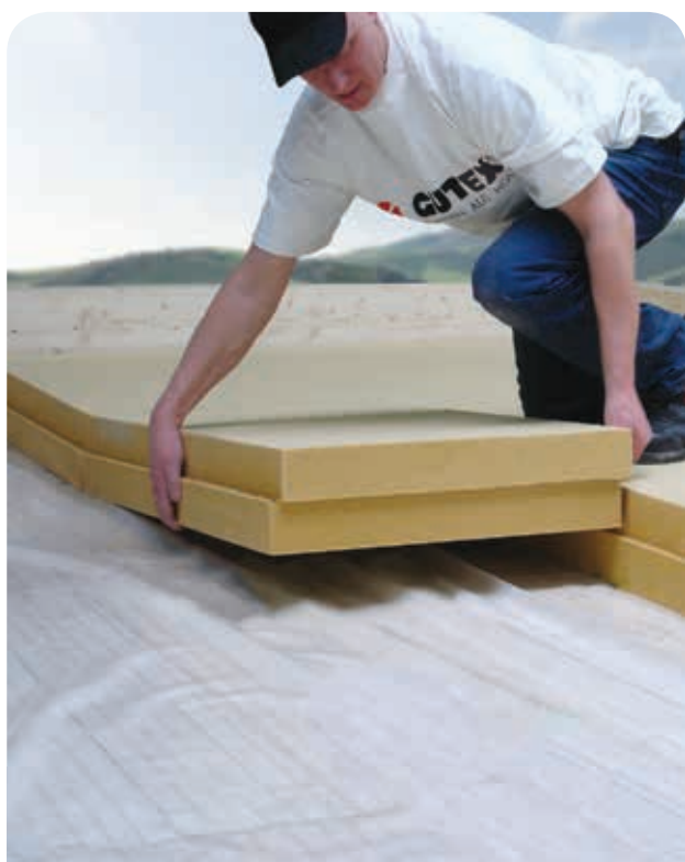
Pose de GUTEX Thermoflat®
