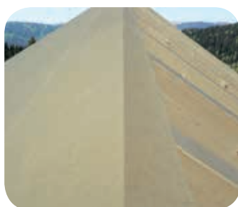
Transition exempte de joints dans la fâche
